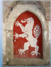
Eingangstür, Wohntrakt. Quelle: http://www.burgenkunde.at/oberoesterreich/piberstein/piberstein28.htm
